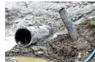
Den första sektionen på 300 meter ner till havet är redan klar och här, i nittiograderskurvan, ska den snart sammanfogas med resterande 600 meter.
