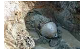
Tittut. Jodå den kom fram efter 17 timmar hemdragning. Nu ligger 600 meter 800 millimeters PE-rör tryggt på plats sju meter ned i marken.
