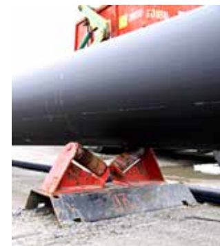
Var tjugonde meter finns V-stöd med rullar så att röret sen kan dras på plats.
