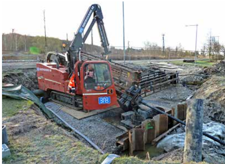
På grund av det begränsade utrymmet med Uddevallavägen precis bakom genomfördes borrning och hemdragning på den kortare 300-meters sträckan med en något mindre maskin, en Ditch Witch JT 100 AT.
