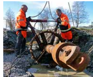
Efter pilotborrningen monteras upprymman, som helt enkelt gör hålet större och samtidigt dras röret på plats.
