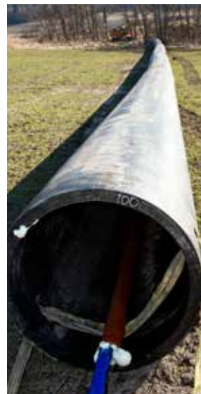
Den nya kulverten är dimensionerad för att klara ett normalflöde på minst 490 liter i sekunden.
