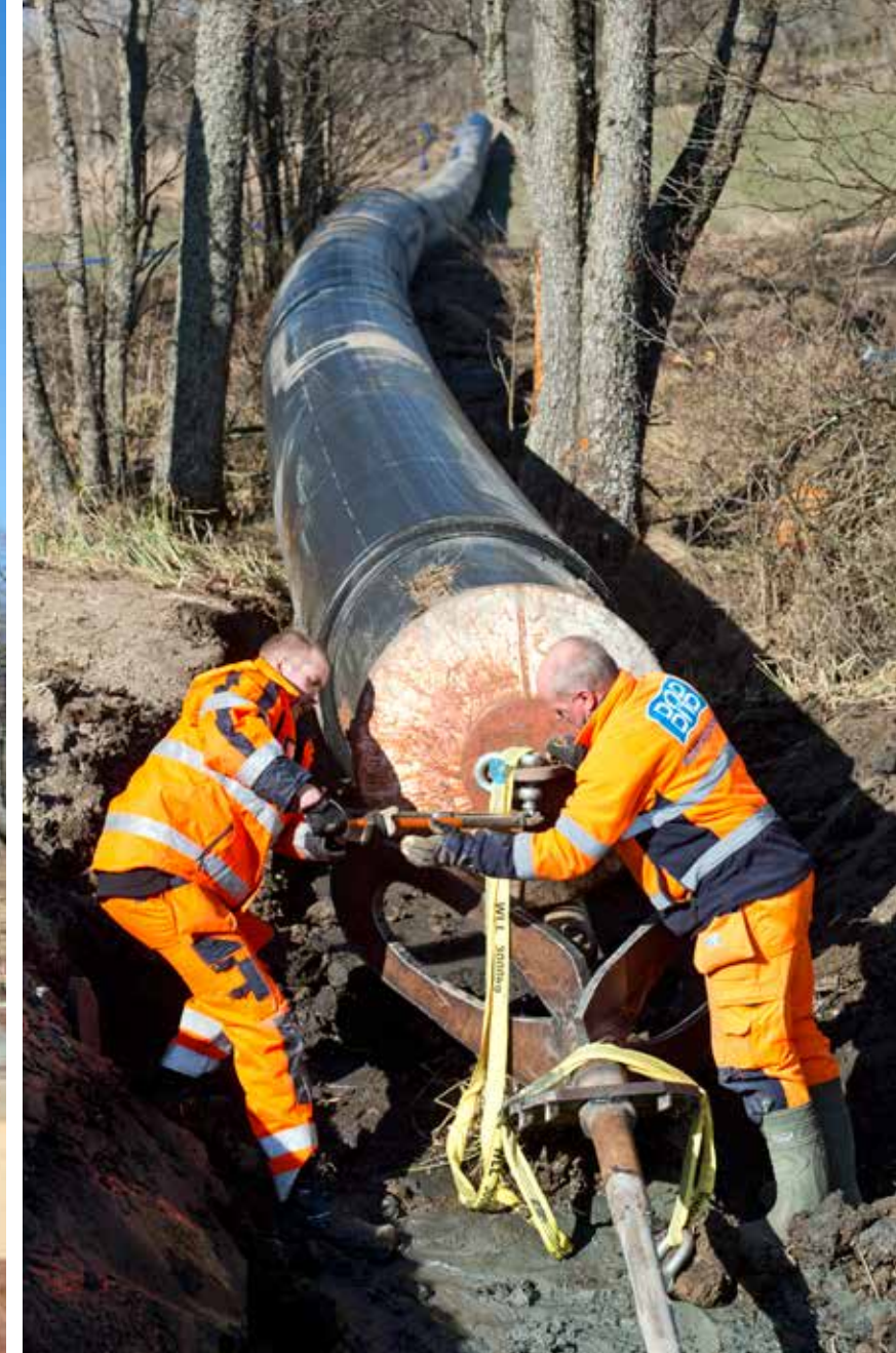
Kristoffer Pettersson (vänster) och Hans Karlsson från BAB drar fast den så kallade upprymmaren innan röret ska börja dras in under kanalen.
