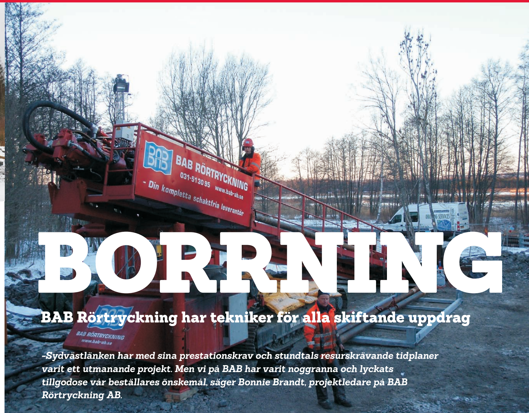
Vid de fall där vi har längre AT-borrningar har vi även tagit in vår DW AT100 som är nordens största rigg för styrd AT-borrning.
